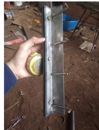
Gambar 5. Lengkungkan Plat Yang Telah Dipotong
