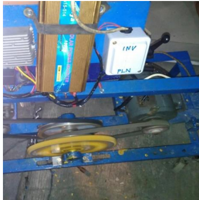
Gambar 3.15 Menyalakan saklar keposisi inverter (Dokumentasi, 2021)
