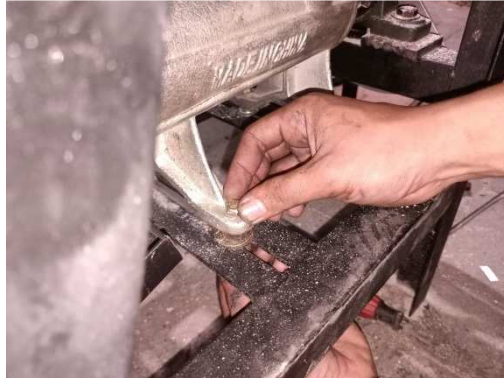
Gambar 4.20 Pemasangan mesin pencetak pelet
