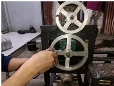
Gambar 4.22 Pemasangan puli 8 inc pengaduk
