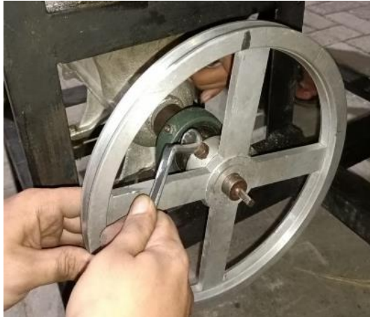
Gambar 3. 15 Pemasangan puli 12 inchi pada pencetak pelet
