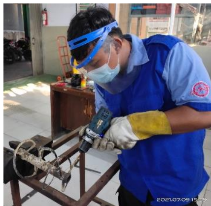
Gambar 4. 24 Proses membuat lubang baut 12
