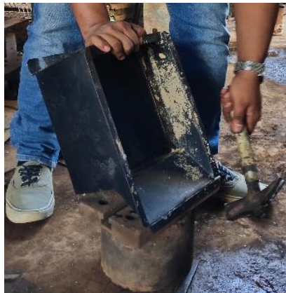
Gambar 4. 13 Proses membuat penyangga dudukan wadah pengaduk
