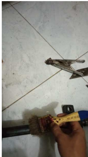
Gambar 4.13 Pengecatan (Sumber: Dokumentasi 2021)
