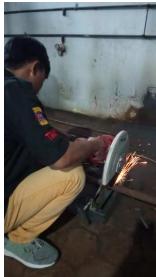
Gambar 4.7 Pemotongan Material (Sumber: Dokumentasi 2021)
