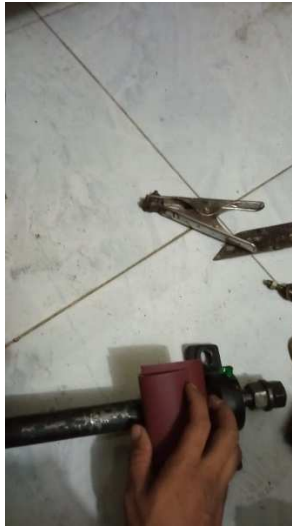
Gambar 4.12 Pembersihan Permukaan (Sumber: Dokumentasi 2021)
