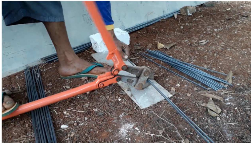
Gambar 4.6 Pemotongan Besi Beton
