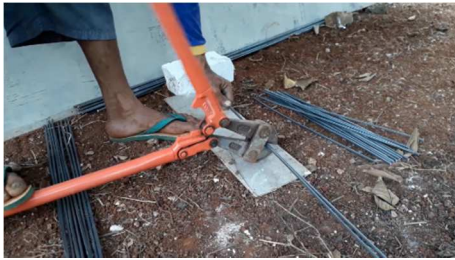
Gambar 7. Pemotongan Besi Beton
