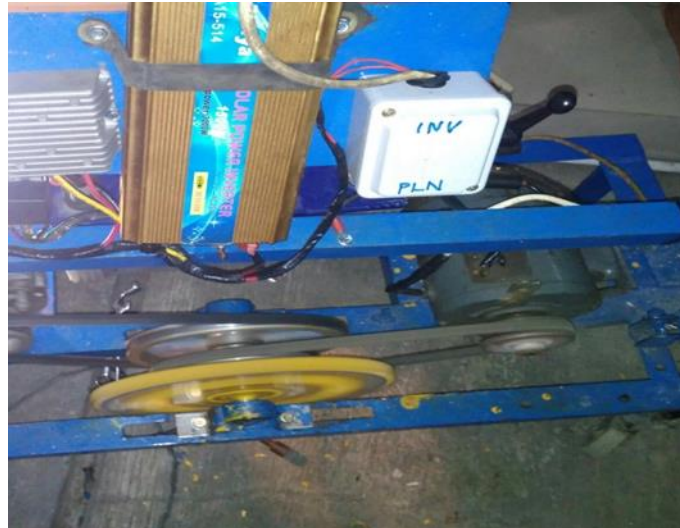
Gambar 3.15 Menyalakan saklar keposisi inverter (Dokumentasi, 2021)
