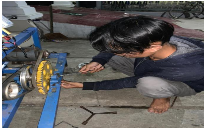
Gambar proses pemasangan rangkain mesin listrik
