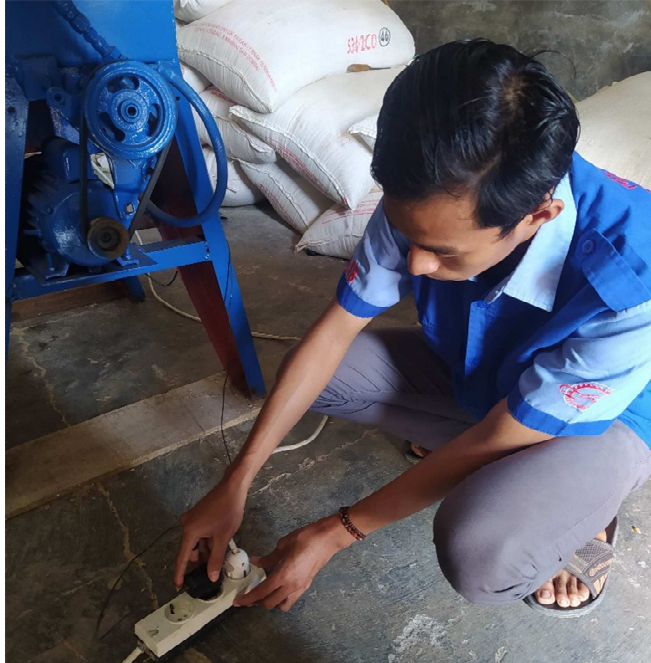
Gambar 3.14 Memasang stopkontak. (Dokumentasi 2021)
