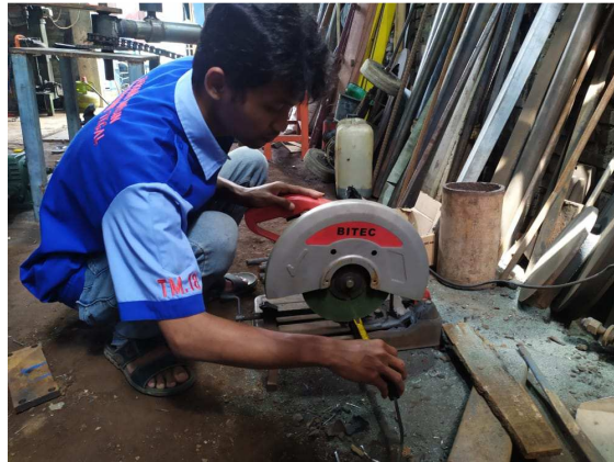
Gambar 3.11 Memotong Benda Kerja Sumber. (Dokumentasi, 2021)
