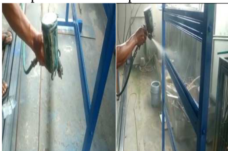
Gambar 7. Proses pengecatan besi kerangka
