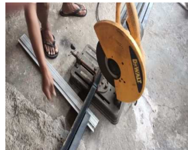
Gambar 2. Pemotongan besi menggunakan gerinda duduk
