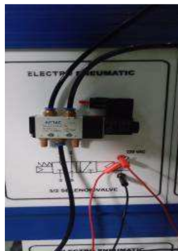
Gambar 4.14 Pemasangan kabel pada solenoid 5/2 (dokumentasi, 2021)
