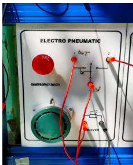
Gambar 4.18 Pemasangan kabel pada emergency switch (dokumentasi, 2021)
