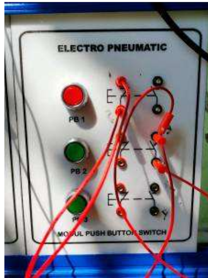
Gambar 4.19 Pemasangan kabel pada push button (dokumentasi, 2021)
