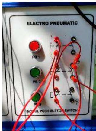
Gambar 4.12 Pemasangan kabel pada push button (dokumentasi, 2021)
