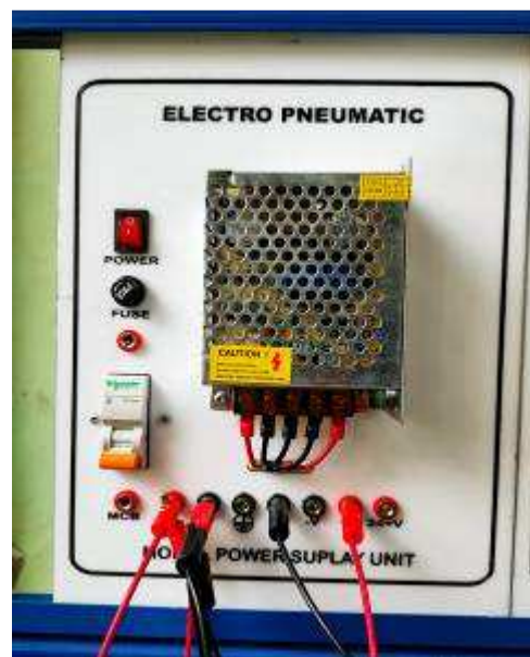
Gambar 4.10 Pemasangan kabel ke power suplay (dokumentasi, 2021)
