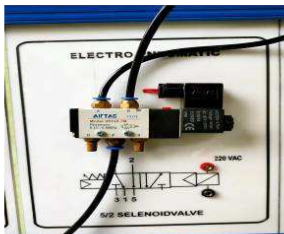
Gambar 4.7 Pemasangan selang di solenoid 5/2 (dokumentasi, 2021)
