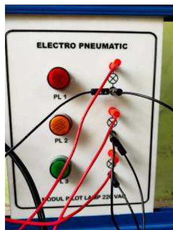
Gambar 4.15 Pemasangan kabel pada lampu (dokumentasi, 2021)
