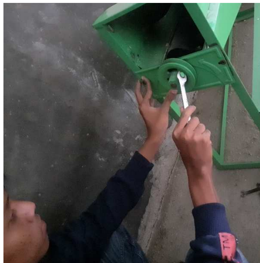
Gambar 3.12 mengatur pulley pada motor disel dan poros mata pisau
