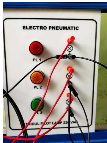
Gambar 4.15 pemasangan kabel pada lampu (sumber: dokumentasi 2021)
