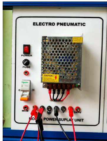
Gambar 4.17 pemasangan kabel ke power suplay (sumber: dokumentasi 2021)
