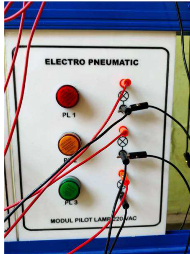
Gambar 4.23 pemasangan kabel pada lampu (sumber: dokumentasi 2021)
