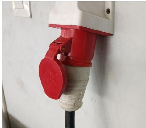
Gambar 3. 12 Menghubungkan Stop kontak 3 *Phase*
