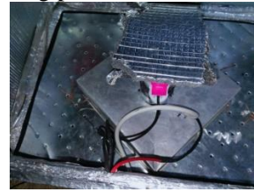
Gambar 5.3 Pemasangan Pemanas Lemari
