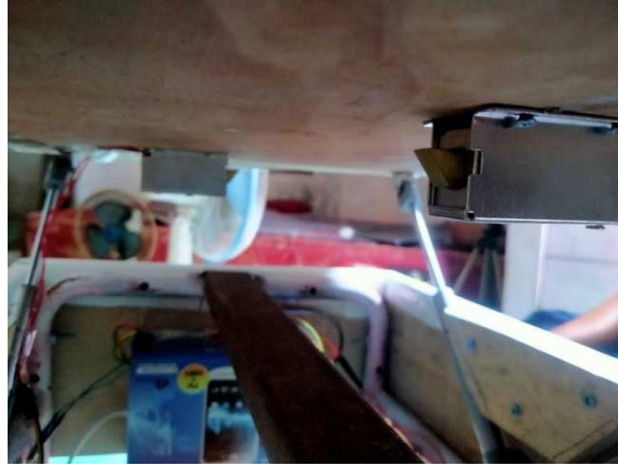
Gambar 5.3. Pemasangan Solenoid Door Lock
