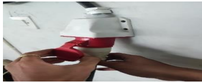
Gambar 3. 12 Pemasangan Stop Contact 3 phase
