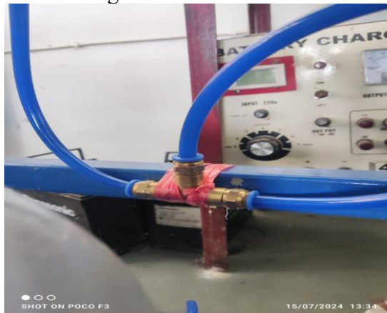
Gambar 3. 15 Sambungkan Untuk Penghubung Selang dari 2 Kompresor
