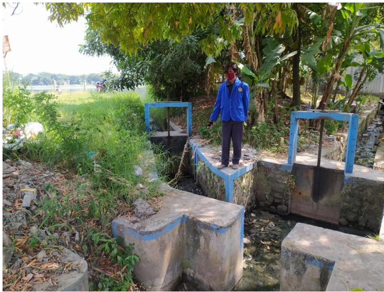
Gambar 3. 4 Jalur keluar masuk air di embung
