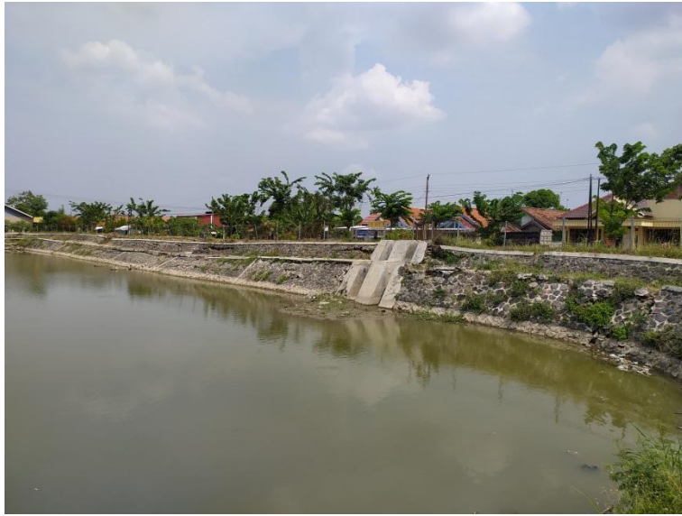
Gambar 3. 5 Kondisi air di embung yang rendah
