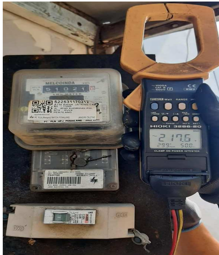
Gambar Proses Pengecekan APP Meter
