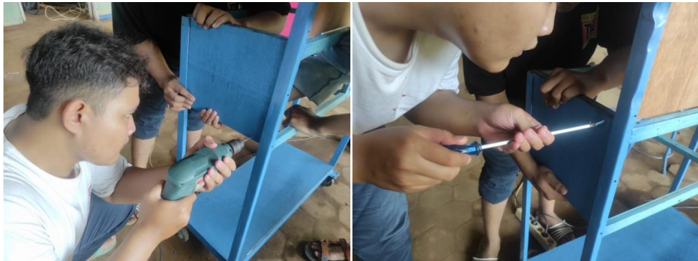
Gambar 4. 19 Pemasangan Papan Pada Trainer
