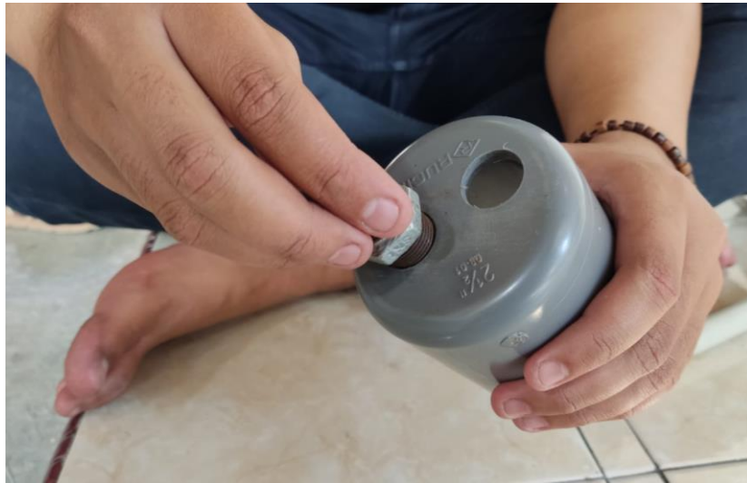
Gambar 4. 10 Pemasangan Nepel Pipa
