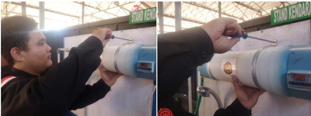
Gambar 4. 20 Pemasangan Water Heater Pada Trainer
