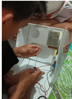
Gambar 4. 12 Pemasangan komponen kelistrikan
