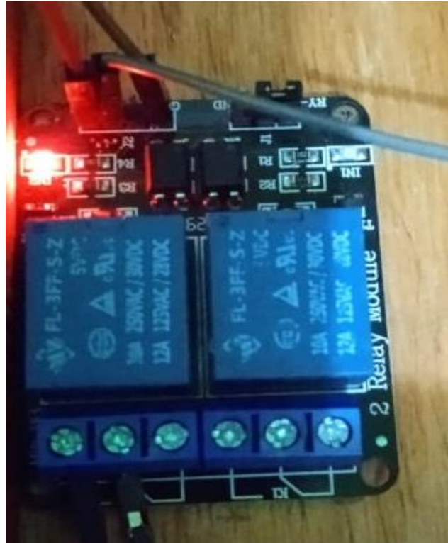
Gambar 5.6 Pengujian pada Relay
